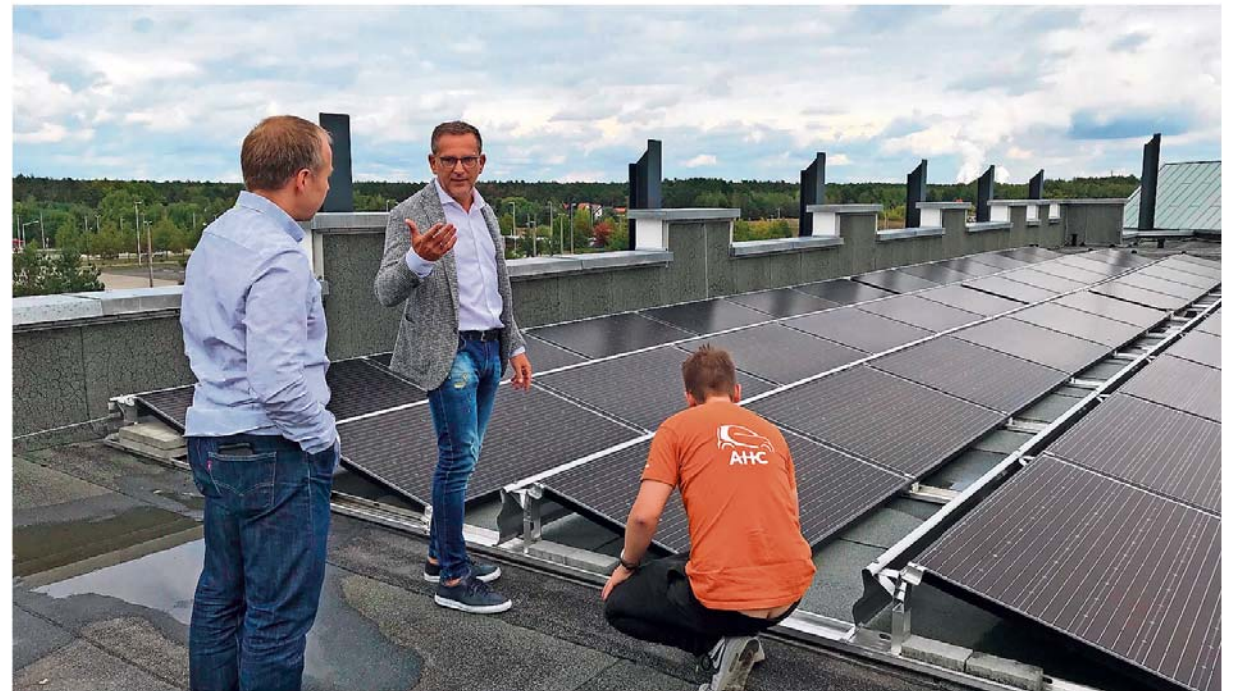
Jan Grawunder (m.) ist begeistert von der Solaranlage, die nicht nur die Büroräume speist: Sie liefert auch den Strom für zwei Auto-Ladesäulen.
