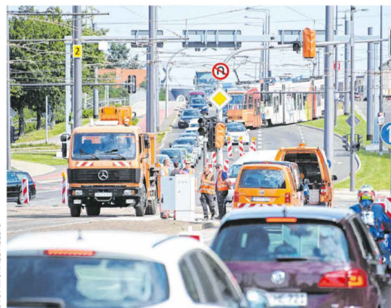
Die Bahnhofskreuzung ist ab Samstag wieder baustellenfrei. Dann geht es für den Autoverkehr wieder zweiseitig über die Kreuzung. Foto: MICHAEL HELBIG
