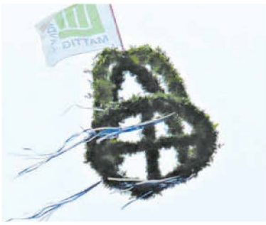
Die Richtkrone wird schnell hinaufgezogen. Die Verpackungshalle soll 2022 bezugsfertig sein.
