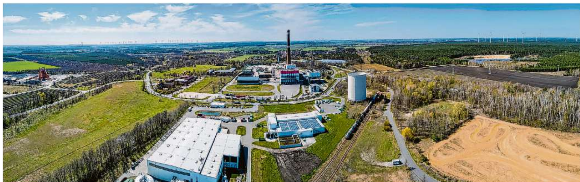
Großer Bahnhof kündigt sich für das Industrie- und Gewerbegebiet „Sonne“ in Freienhufen an. Europas führender privater Eisenbahngüterwagen-Vermieter und Schienenlogistiker VTG siedelt sich an (Baustelle vorn rechts). Eine Investition im zweistelligen Millionenbereich. Zur Grundsteinlegung am 29. Juni kommt auch Brandenburgs Infrastrukturminister Guido Beermann (CDU).
