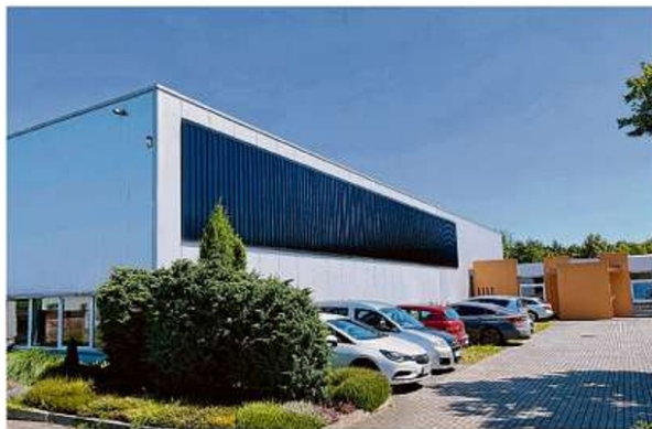
Diese Kollektorfassaden werden inzwischen deutschlandweit montiert. Foto: Maik Sommer/Etapart AG
